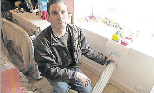
Colette Queinnec a décidé de faire isoler sa maison : elle espère voir sa facture annuelle passer de 1 000 à 700 €. Avant d'isoler, un cabinet indépendant vérifie la présence de ponts thermiques. Grâce à un tuyau, la fibre isolante est propulsée directement dans le mur.
