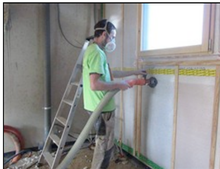
Le technicien insuffle l'isolant derrière le pare-vapeur avant la pose de la plaque de plâtre.
