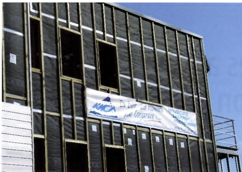
La pose de tasseaux de 40 x 40 voire 40 x 45 est privilégiée pour atteindre une lame d'air suffisante entre le pare-pluie et le bardage.
