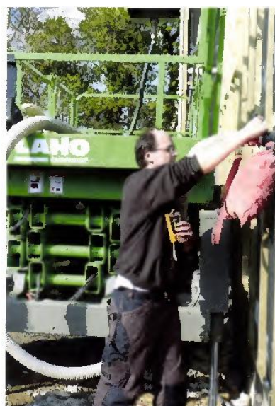
La ouate de cellulose est insufflée à une densité de 57,5 kg/m 3 (ici à l'orée de Keraliou).
