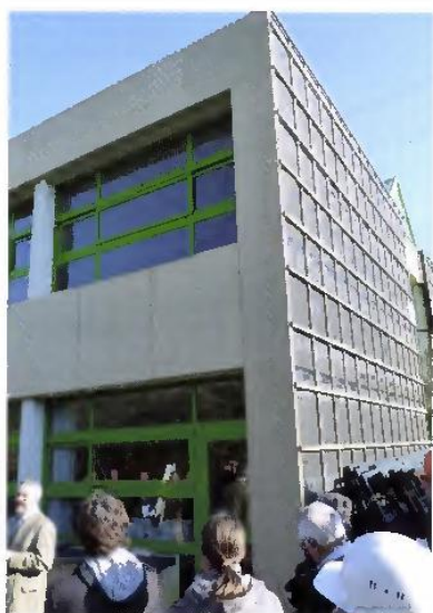
L'institut de Rumengol rénové thermiquement fait appel à un nouvel isolant en laine minérale de verre de type Supafil Cavity Wall 034.
