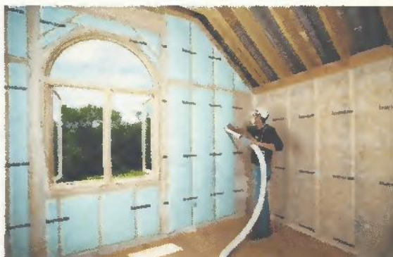
La technique associe une structure en bois posée sur la maçonnerie existante et un isolant minéral soufflé derrière le pare-pluie.
