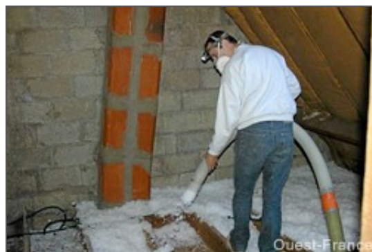
L'isolation par insufflation représente l'essentiel du marché de la rénovation.
