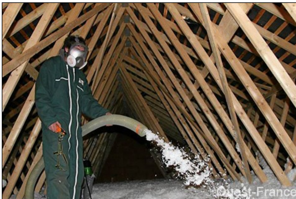
Un professionnel de chez Qualiconfort est en train d'isoler les combles.
